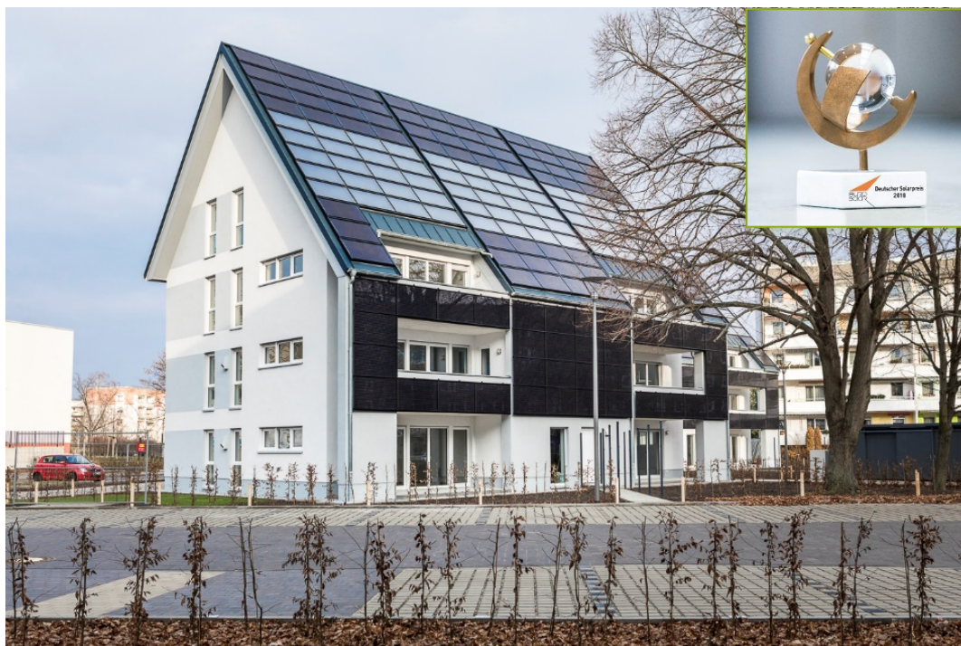
↗ Abb. 5: Zwei fertiggestellte energieautarke Mehrfamilienhäuser in Cottbus. Quelle HELMA. Dieses Projekt wurde mit dem Deutschen Solarpreis 2018 geehrt. Quelle: Eurosolar
