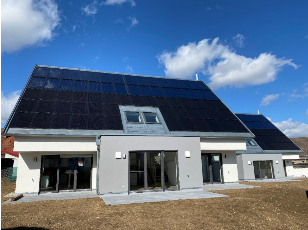
➤ Abb. 9: Als erste Bank Deutschlands baute die VR-Bank Ostalb eG Aalen 2019 in Aalen zwei energieautarke Mehrfamilienhäuser mit je drei Wohneinheiten, welche mit Pauschalmitte und Energieflat vermietet werden. Wärme, Strom und zukünftig auch E-Mobilität sind in der Miete bereits enthalten.
