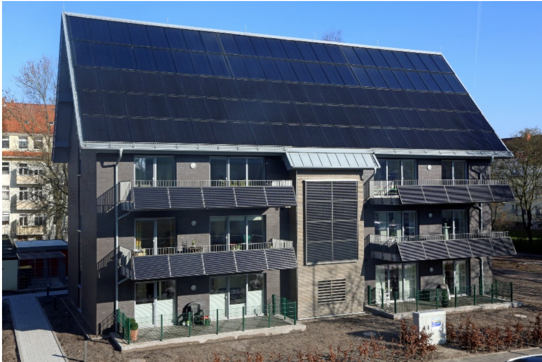
Abb. 7: Miete mit Energieflat: Ein vermietetes energieautarkes Mehrfamilienhaus mit je 6 Wohneinheiten in Wilhelmshaven, Fertigstellung 2018. Solartechnik auf dem Dach und an den Balkonen mit Energiespeicher erreichen etwa 70 Prozent solare Deckung des Strom- und Wärmebedarfs. Der Vermieter bietet dem Mieter für 10 Jahre eine Pauschalmiete an, in der Wohnen, Wärme, Strom und E-Mobilität als Flatrate bereits enthalten ist.
