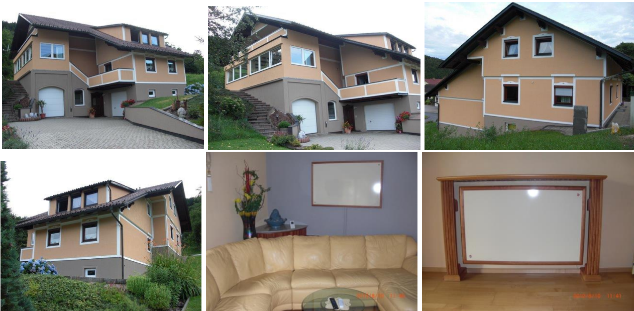
Bild 3: Außenansichten des Testobjektes und Beispiele von Montageplätzen der hocheffizienten Infrarotheizung im Inneren nach der Umrüstung
